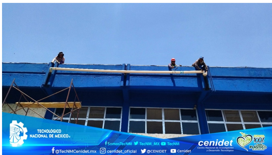
Ilustración 139. Recolector de agua pluvial
