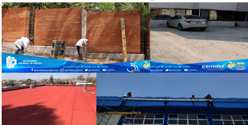
Ilustración 50. Mantenimiento a la infraestructura
